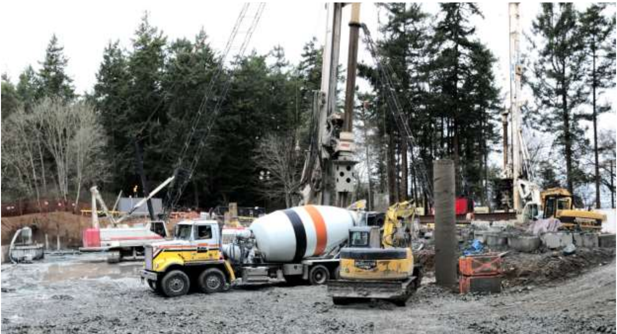
Figure 28–Arbutus Attenuation Tank- Concrete pour for Secant Pile.
